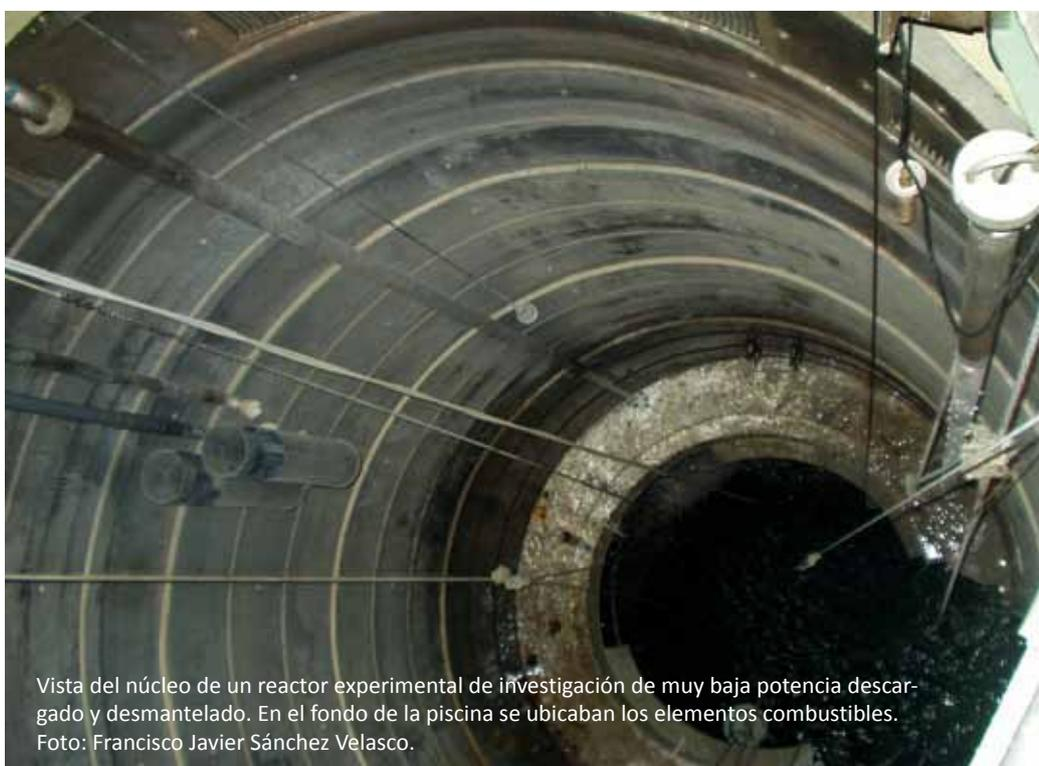
Vista del núcleo de un reactor experimental de investigación de muy baja potencia descargado y desmantelado. En el fondo de la piscina se ubicaban los elementos combustibles. Foto: Francisco Javier Sánchez Velasco.
